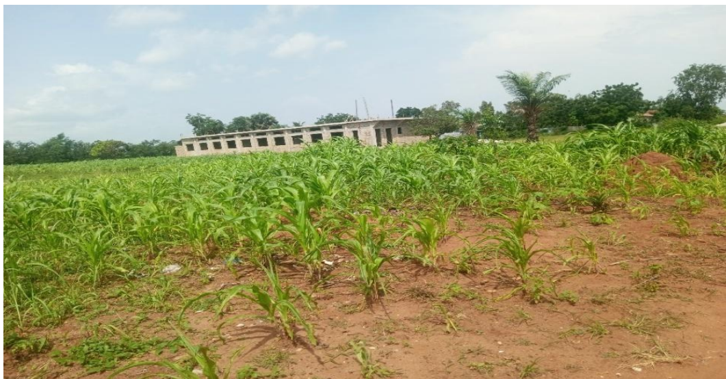
Photo 1: Bâtiment en construction au milieu d'un champ dans l'arrondissement de Glo
